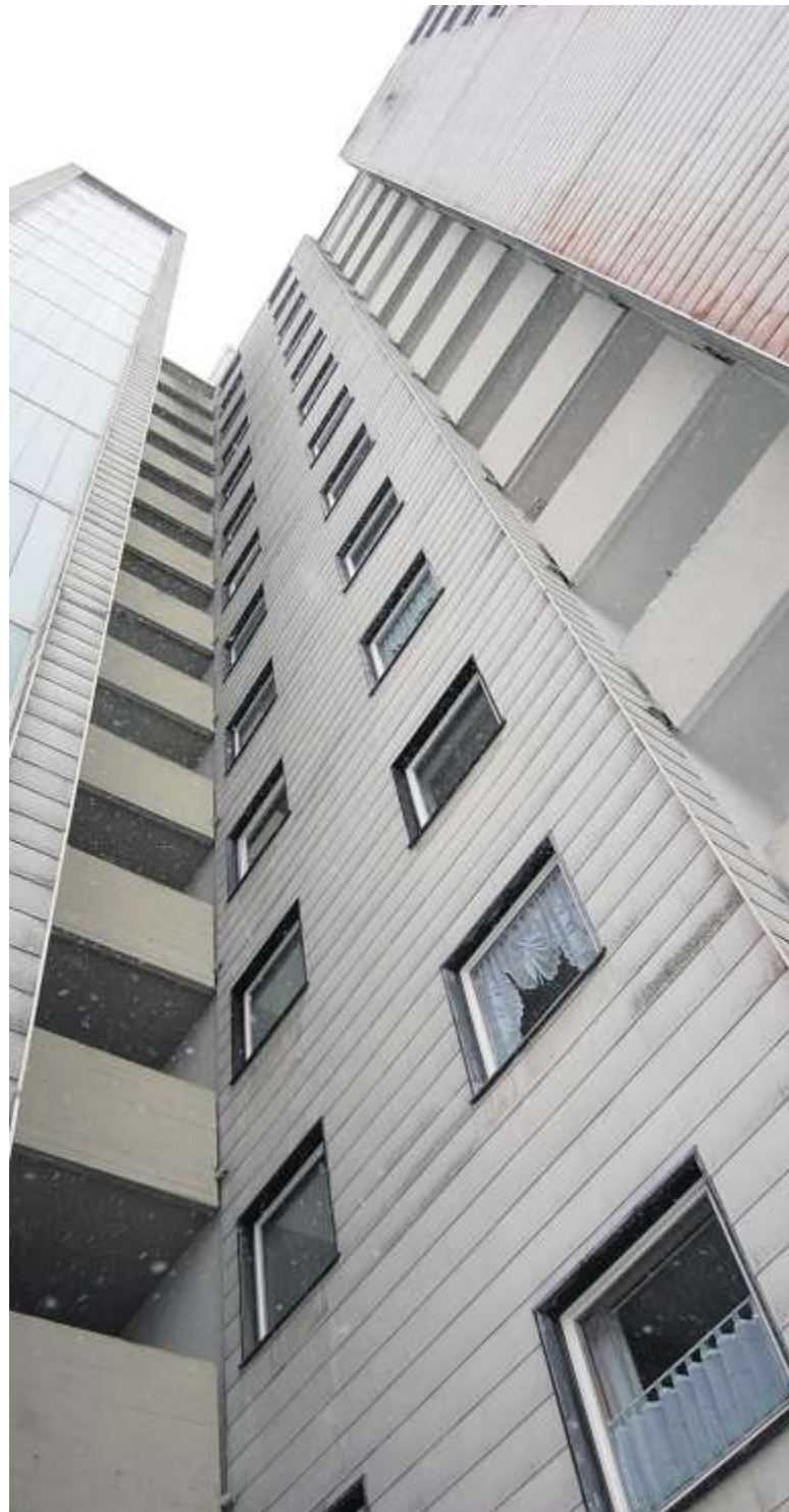
Das Hochhaus Kurt-Schumacher-Straße 23 wird von der Stadtbau GmbH generalsaniert. Viele Mieter sind darüber nicht glücklich. Foto: Archiv
