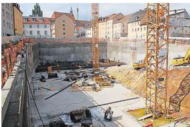
**Bohrpfähle, Durchmesser 70 Zentimeter, sichern die Grube ab. Von der Straße aus geht es neun Meter in die Tiefe und dann noch einmal fünf bis zehn Meter, bis zum Fels.**
