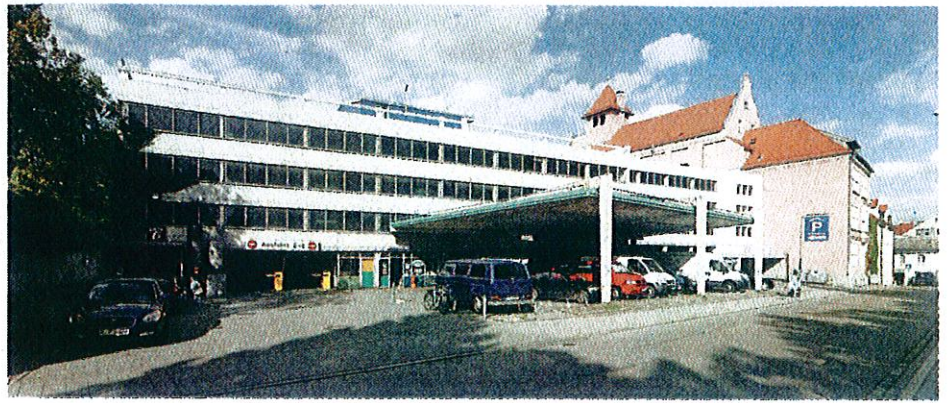
→ Das 1966 errichtete Parkhaus wird voraussichtlich 2012/2013 durch einen Neubau ersetzt
